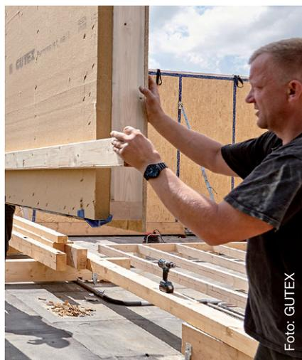
Kaum ein Dämmstoff sorgt für ein behaglicheres Zuhause als die natürliche Holzfaser. Zudem schützt sie hervorragend vor Lärm und Hitze. Die im Trockenverfahren hergestellte Holzfaserdämmplatte des Schwarzwälder Dämmstoffherstellers erreicht die Brandschutzklassifizierung C-s1,d0 und nicht glimmend. Damit erfüllt GUTEX Pyroresist die gesetzlichen Brandschutzanforderungen für die Dämmung von Fassaden gemäß Musterbauordnung. Auf Brandschutzriegel in der WDVS Fassade kann daher verzichtet werden.
