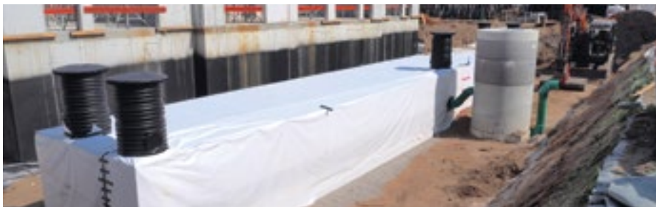
Die Module wurden vor Ort zu einem kompakten Verbund vormontiert und mit GRAF-Tex Geotextil umschlossen
