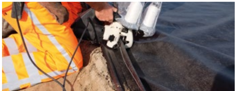
Mit der neu entwickelten Broof-Tech Stitch® Technik werden die überlappenden Streifen des Unkrautvlieses versiegelt
