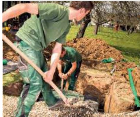
Mit Rundkornkies wird aufgefüllt und verdichtet. 93-04
